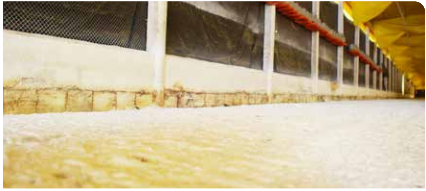
A calagem deve ser feita de forma uniforme, também nas muretas e pilares.
