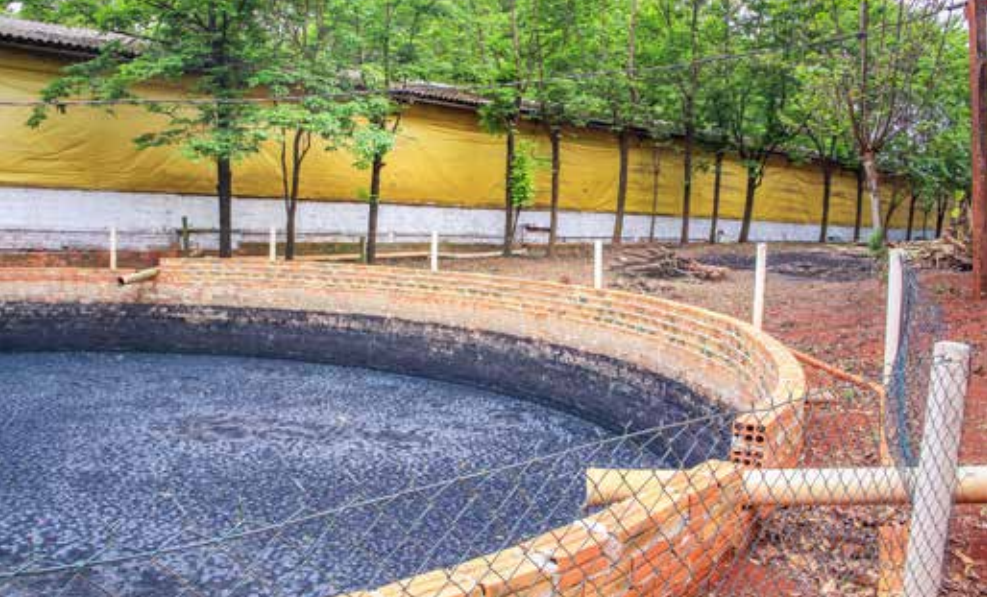
A composteira deve ser devidamente manejada, conforme orientação dos técnicos e sua estrutura deve ser isolada de forma correta
