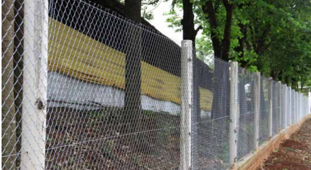
A cerca construída com mureta e tela evita o acesso de animais silvestres
