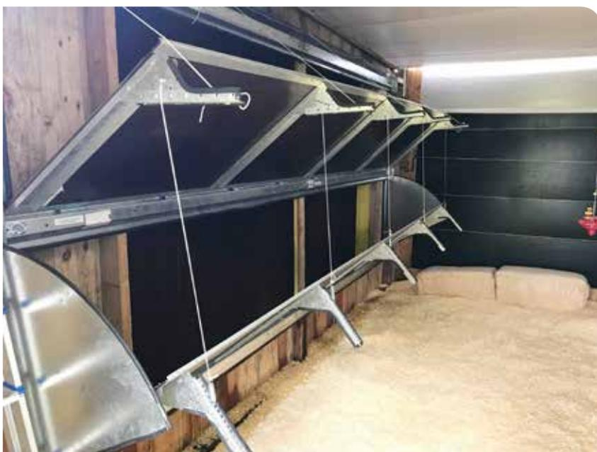
O túnel door pode substituir a cortina junto à placa evaporativa para proporcionar uma vedação total
