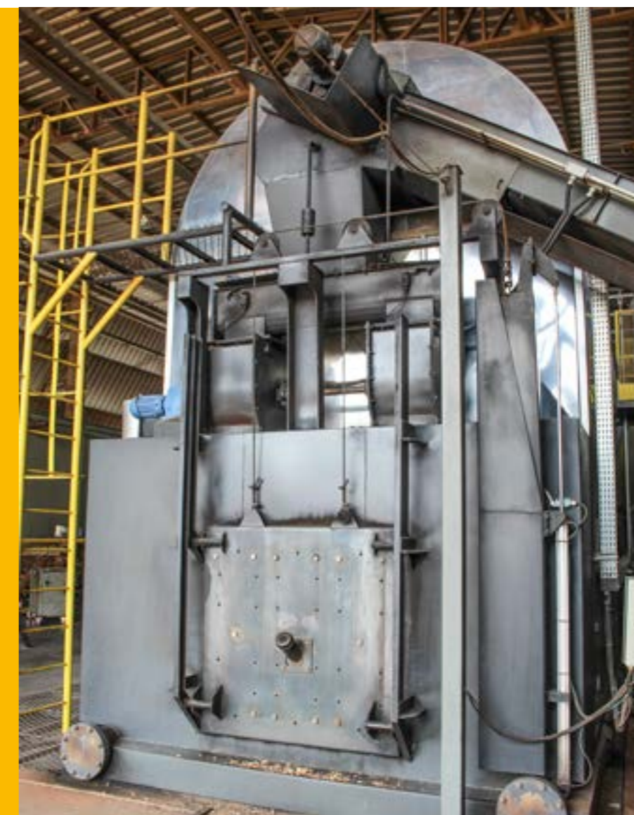
CALDEIRA DA INDÚSTRIA CONSOME 70 TONELADAS DE CAVACO POR DIA
